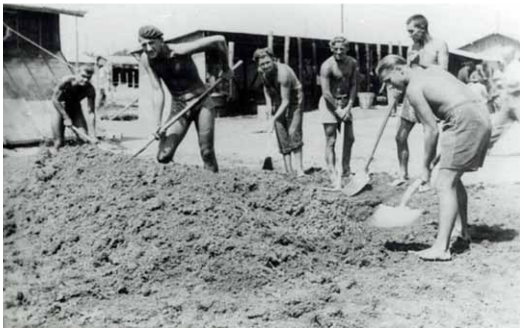
Un groupe de six internés prépare le terrain sur lequel va être érigé une statue de glaise. (Gurs, été 1939) Collection G. Stroppolo
